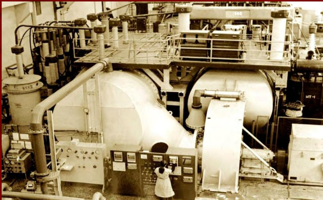
**Частотно-импульсный лазер ЗД01~ 1 МВт класса с ионизацией электронным пучком был построен в 1976-78 г.г. в ЦКБ «Луч» по предложению и при участии Н.Г.Басова и его сотрудников в ОКБ «Радуга» (позже –ГНИИЛЦ). Средняя мощность его ~ 500 КВт при частоте повторения до ~ 200 Гц. Использовалась схема с «замкнутым» газодинамическим контуром . Позже был создан усовершенствованный лазер...**
